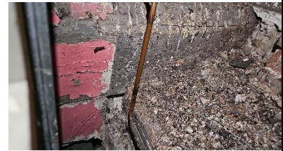
Photo n°43 : Bâtiment central, niveau 3, sanitaire à côté de la sortie vers ascenseur, about du blochet compris dans le doublage de la cloison
