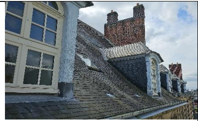
Photo n°165 : Bâtiment D, façade nord, décollement de l'habillage de la joue de la lucarne
