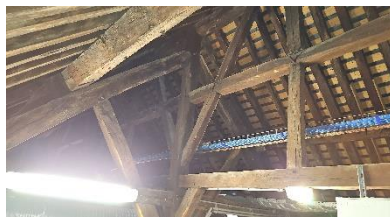
Photo n°31 : Bâtiment central, ferme numéro 6 versant sud, niveau faîtières et poutre au vent
