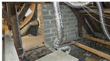
Photo n°35 : Bâtiment central, ferme numéro 10, vue de l'entrait de ferme et du plenum du niveau 3
