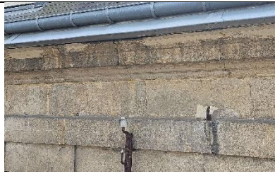
Photo n°142 : Bâtiment central, façade nord pavillon, détails joints lessivés de la corniche
