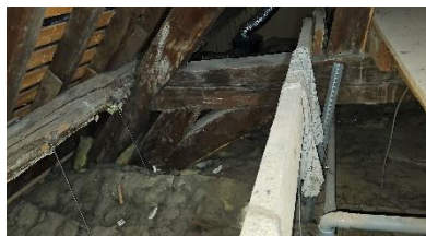
Photo n°34 : Bâtiment central, détail de l'entrait de la ferme 9 sous le plancher du comble
