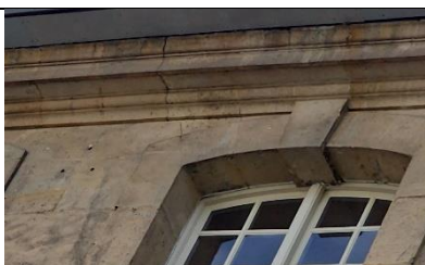
Photo n°153 : Bâtiment D, dit photo précédente, détails joints lessivés de la corniche
