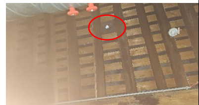
Photo n°39 : Bâtiment central, trou dans la toiture
