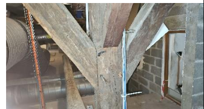
Photo n°36 : Bâtiment central, ferme numéro 10, cheville lâche à remplacer
