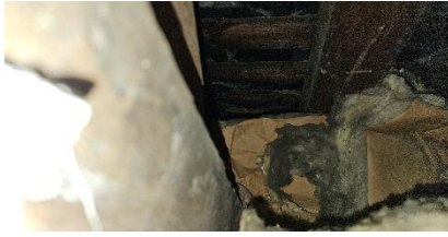
Photo n°52 : Bâtiment D, bureau D305, sondage réalisé en pied de ferme ; les nombreuses épaisseurs d'isolants n'ont pas permis de faire une observation exhaustive du pied de ferme, à moins de tout déposer.
