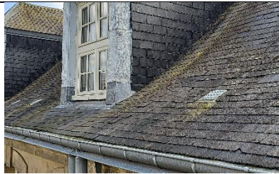
Photo n°166 : Bâtiment D, façade nord, moutonnement de la couverture
