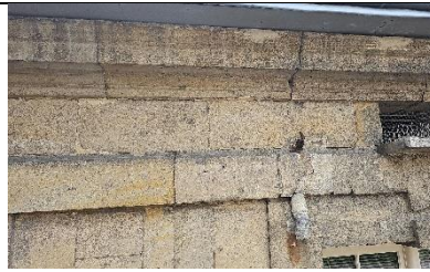
Photo n°143 : Bâtiment central, façade nord pavillon, détails joints lessivés de la corniche
