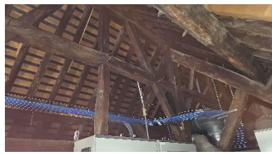
Photo n°32 : Bâtiment central, ferme numéro 8, versant sud, poutre au vent entre les fermes 7 et 8, trace blanche sur extrados de l'arbalétrier, humidité
