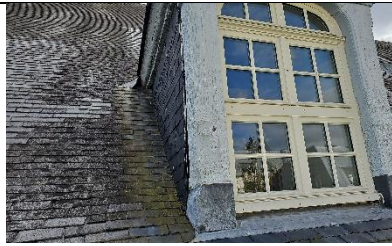
Photo n°163 : Bâtiment D, façade nord, décollement de l'habillage de la joue de la lucarne
