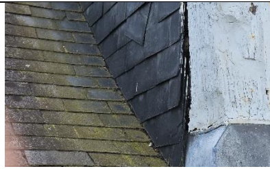
Photo n°164 : Bâtiment D, façade nord, décollement de l'habillage de la joue de la lucarne
